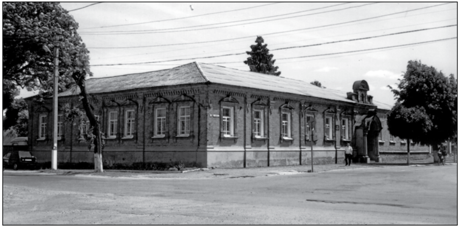
Усадебный дом Николаенко по ул. Путивльской, 1. Фото автора
