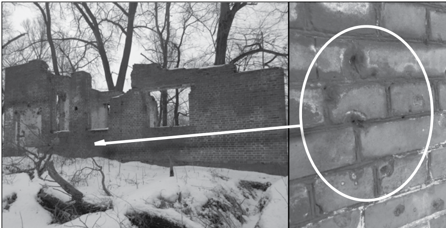
Руїни водокачки біля Павлівського озера та фрагмент стіни, подовженої кулями
