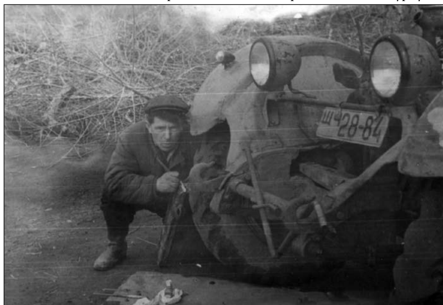
Водитель-механик во время ремонта детдомовского грузовика ЗИС-5
