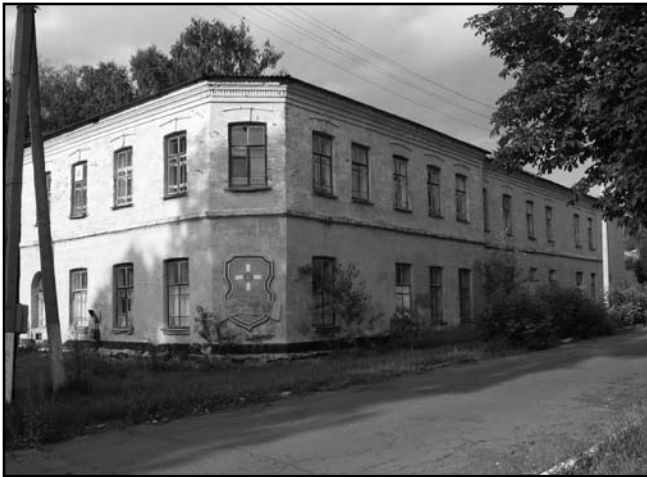
Рис. 5. Будівля двоповерхової штабної казарми 175 Батуринського полку. 2010 р.
