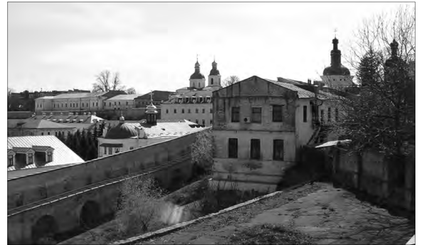
Рис. 1. Вид на східний фасад корпусу № 31
