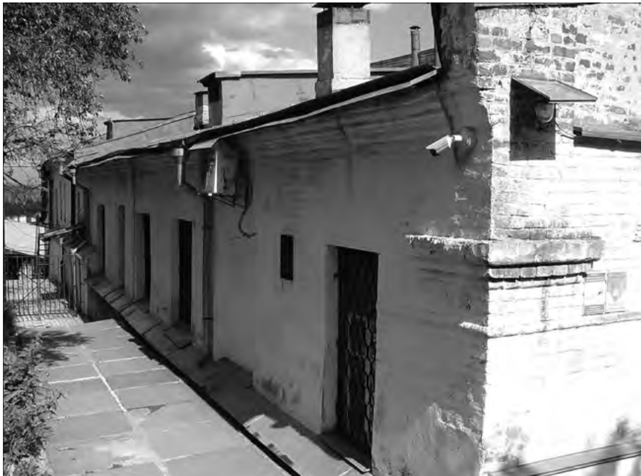
Рис. 5. Улаштування фальш-цоколів на північному фасаді корпусу № 31
