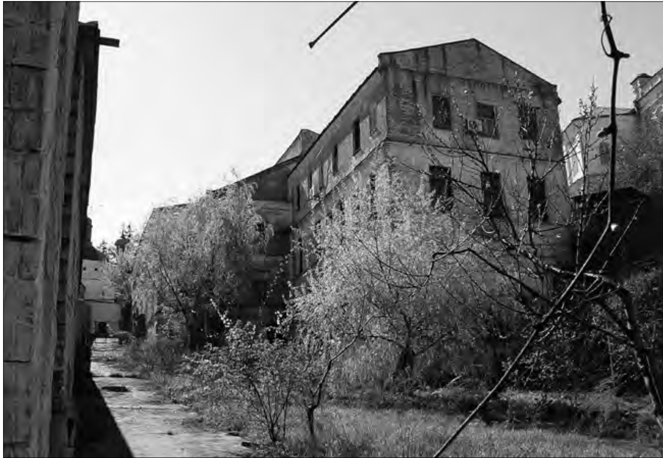
Рис. 2. Загальний вигляд південного та східного фасадів корпусу № 31
