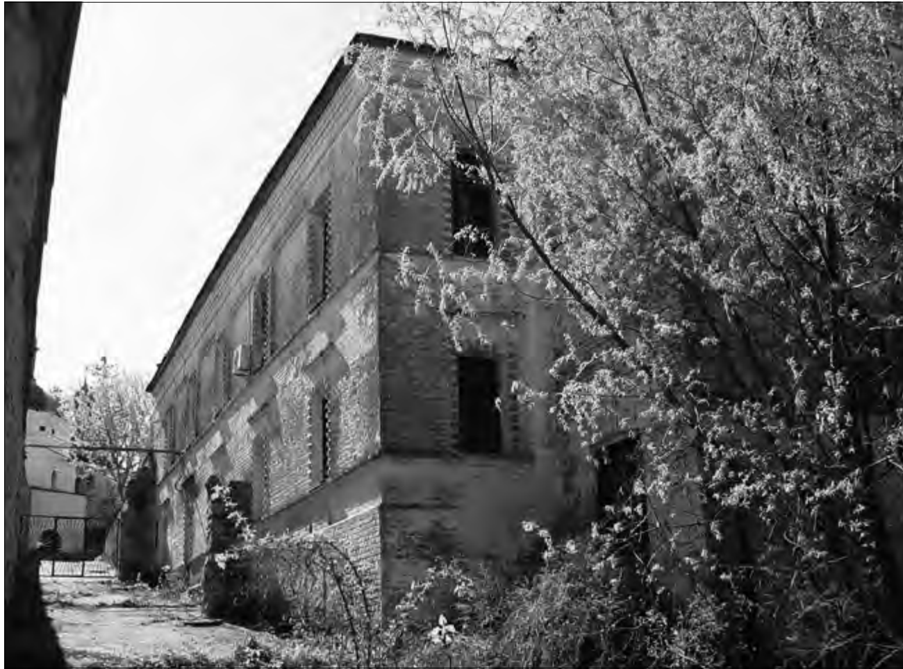
Рис. 4. Фрагмент південного фасаду корпусу № 31 з незавершеним благоустроєм території
