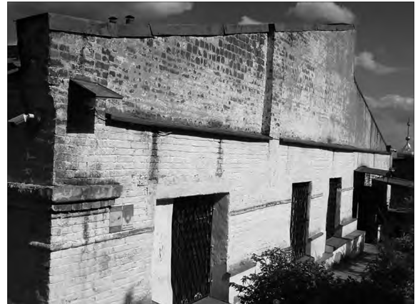
Рис. 6. Західний фасад корпусу № 31
