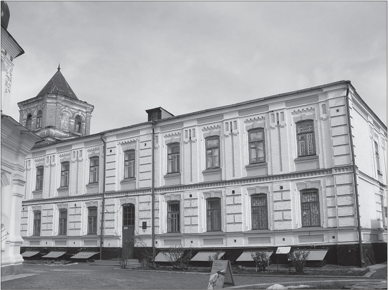
Іл. 5. Пам'ятка архітектури «Аптека», корпус № 24, фрагмент західного фасаду південного крила будівлі
