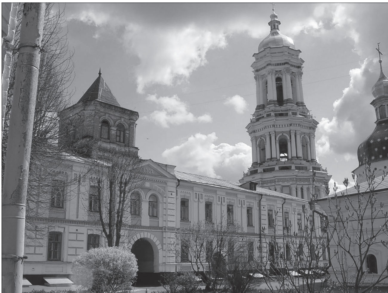
Іл. 4. Пам'ятка архітектури «Аптека», корпус № 24, фрагмент західного фасаду будівлі
