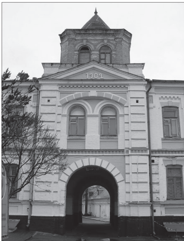
Лл. 2. Пам'ятка архітектури «Аптека», корпус № 24, центральна частина будівлі з наскрізним арковим проїздом, над другим поверхом якої височить чотиригранна зі зрізаними кутами дзвіниця; до пожежі 2008 р. була увінчана гранчастотою банею з цибулиноподібною маківкою та шпилем (наразі з тимчасовим накриттям)
