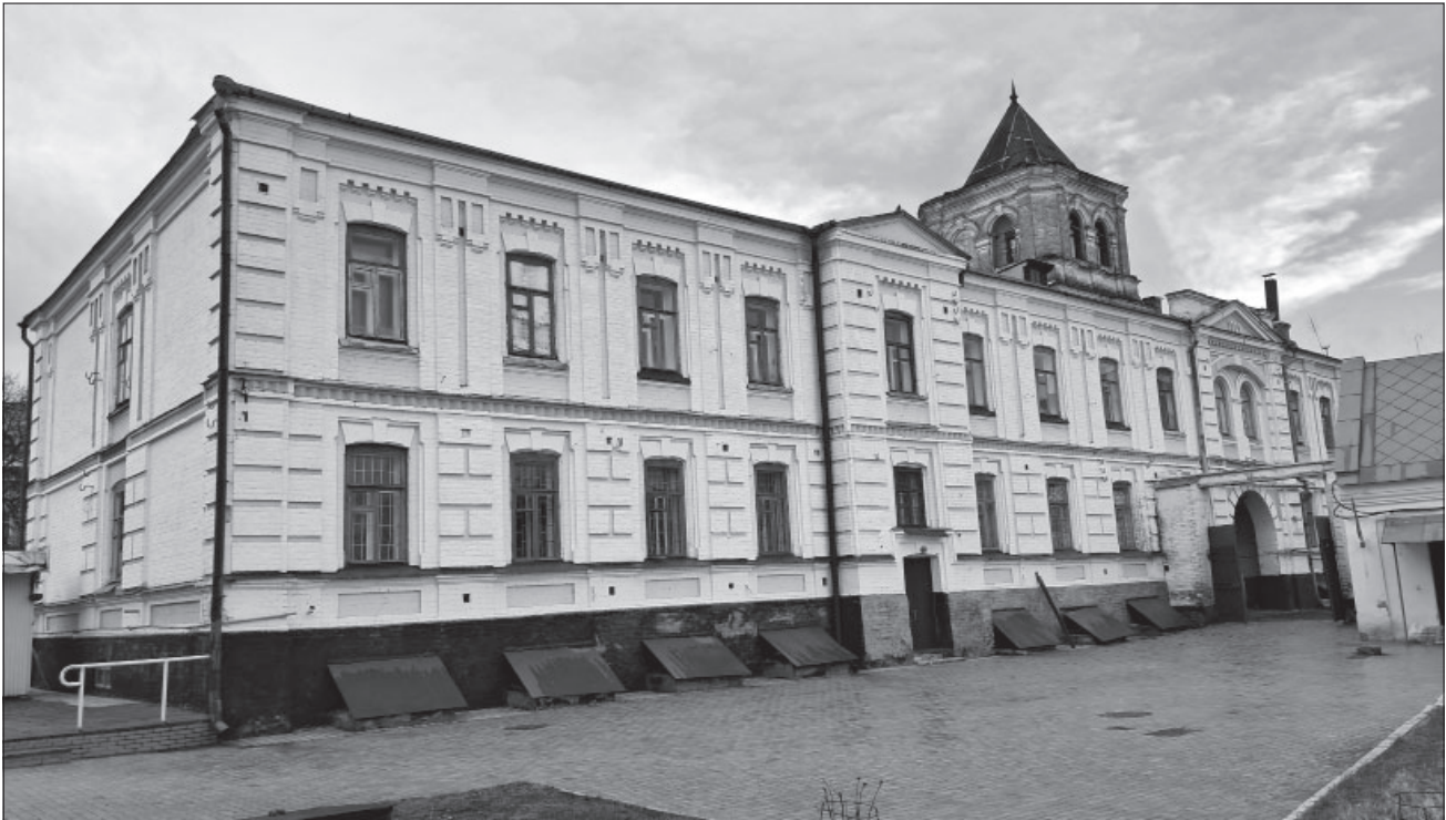
Іл. 1. Пам'ятка архітектури «Аптека», корпус № 24, фрагмент східного фасаду південного крила будівлі
