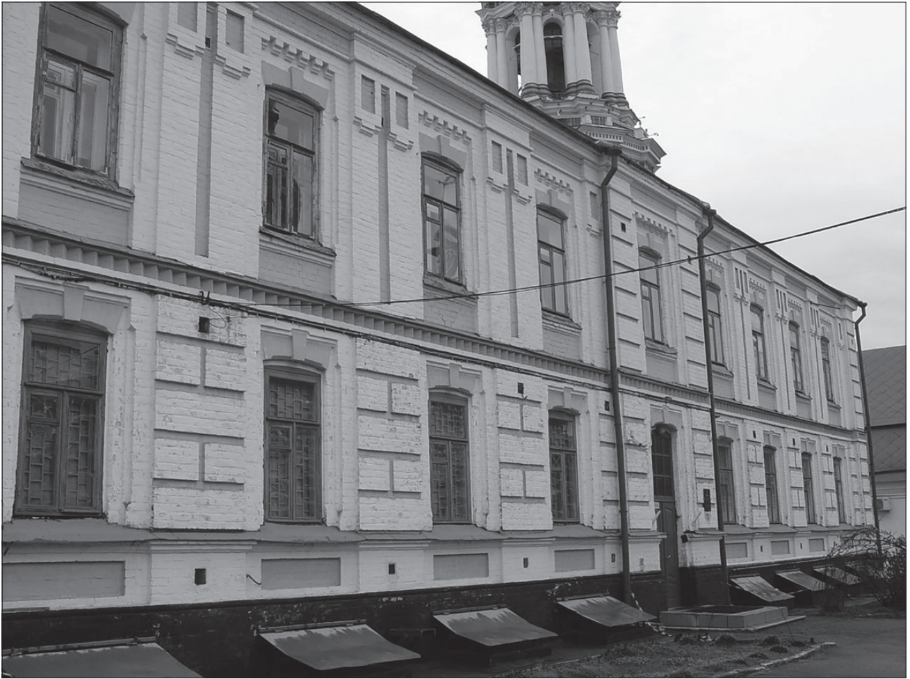
Іл. 6. Пам'ятка архітектури «Аптека», корпус № 24, фрагмент західного фасаду будівлі
