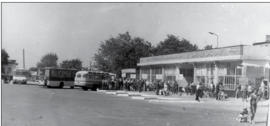
Автостанція «Глухів» (1979 р.)
